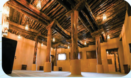
مسجد تاريخي بعد ترميمه
